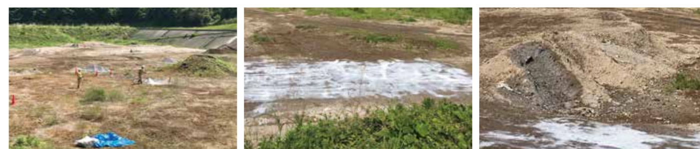
廃棄物最終処分場（茨城県） 覆土削減、場内の粉塵飛散防止を目的とした埋立場、走路への散布
