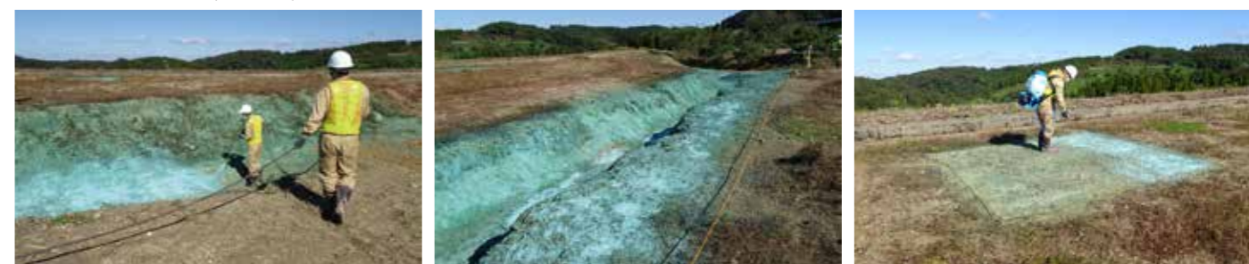
廃棄物最終処分場（石川県） 浸透雨水調整を目的とした場内雨水側溝への散布
